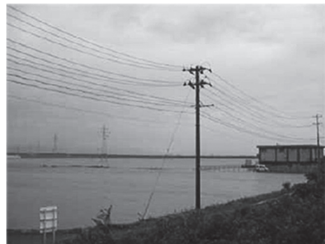
写真8 地区内湛水状況（2011（平成23）年6月）
