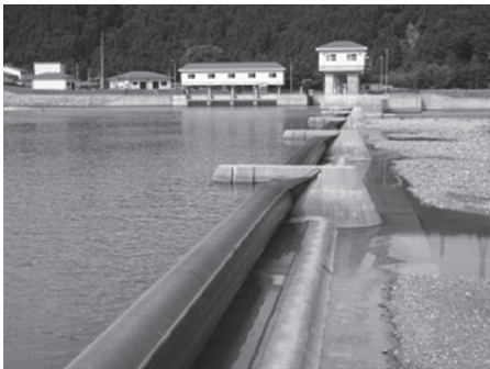
写真5 北楯頭首工（改修後）
