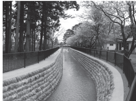
写真7 余目堰用水路
