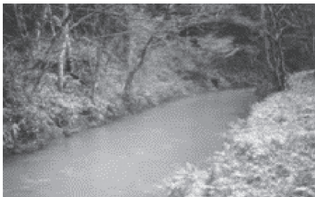
写真2 北楯大堰用水路(改修前)
