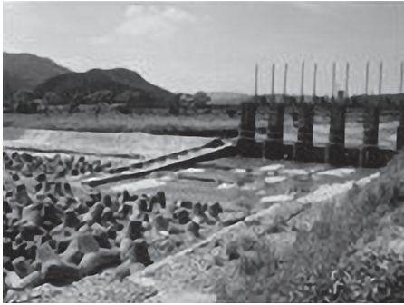
写真4 北楯頭首工（改修前）
