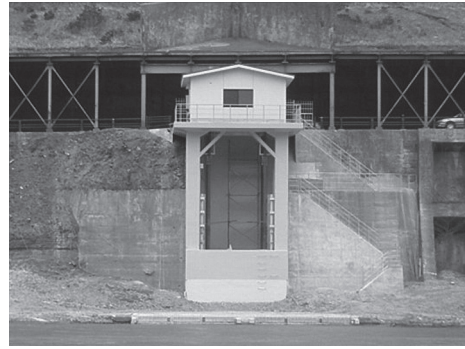
写真6 最上川取水口
