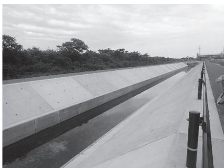
写真 14 中央排水路（改修後）
