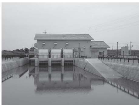
写真 13 中央排水機場（改修後）
