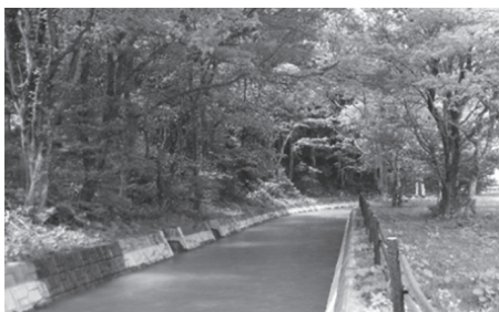
写真3 北楯大堰用水路(改修後)
